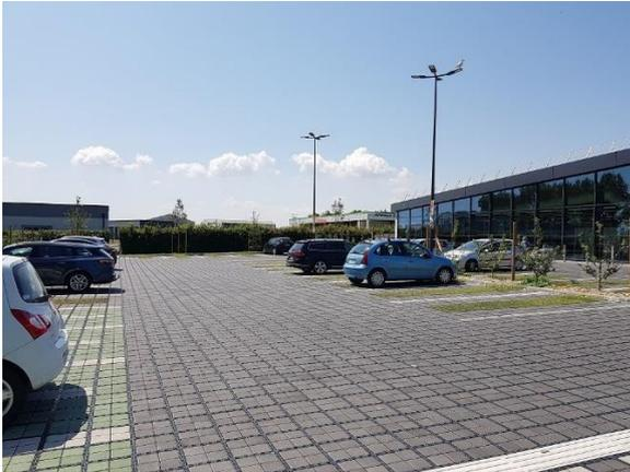
Il s'agit de dalles conçues pour laisser passer l'eau. Cet équipement est aujourd'hui une tendance-clé de l'aménagement de places de parking, l'objectif étant d'offrir un revêtement perméable et une durabilité optimale.
